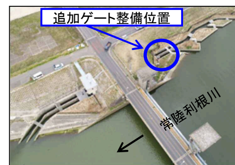
常陸川水門魚道
