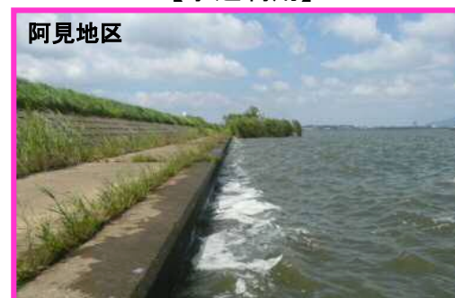
水際が垂直で緩衝部がなく、安全に利用できない
