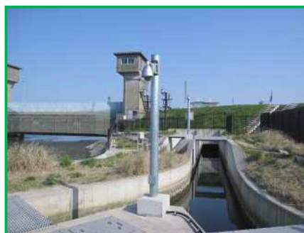
III.常陸川水門(カメラ設備)
