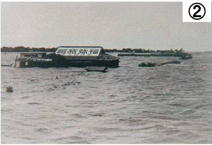
浸水状況【横利根川】
