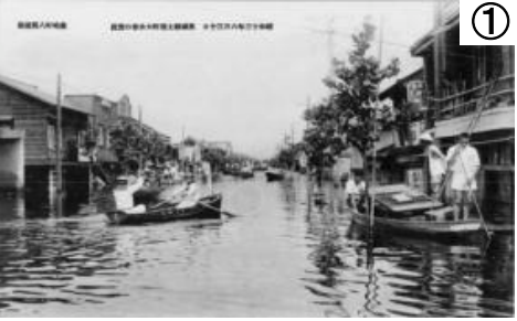
浸水状況【土浦市内】
