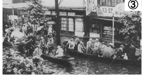
浸水状況【土浦市内】
