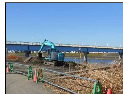
現場発生土を築堤材料 として再利用
