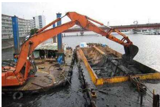
河道掘削施工状況 (下野谷町地先の事例)
