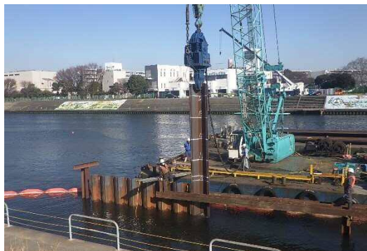
河岸防護施工状況 (下末吉地先の事例)
