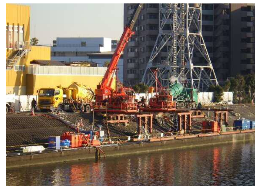
耐震対策施工状況(高压噴射攪拌工法) (元宮地先の事例)
