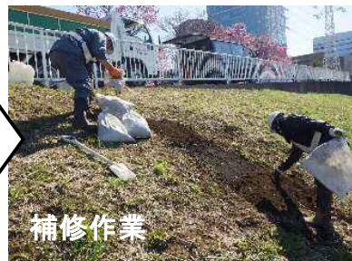
法面陥没した堤防の補修(鳥山川)
