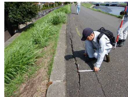
堤防点検(鶴見川)
