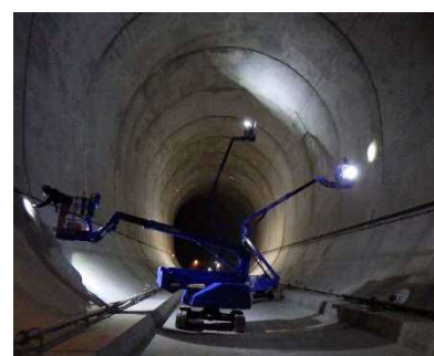
トンネル点検作業
