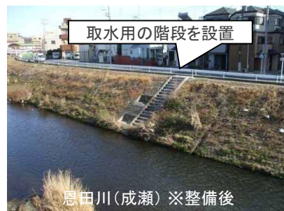
護岸の形状により取水が困難な箇所の整備
