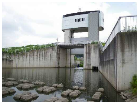
排水門の点検
