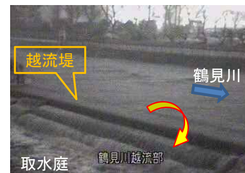
調節池への流入状況(写真)
