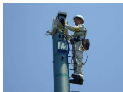
CCTVの点検作業
