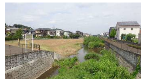
宮川橋下流で整備した緩傾斜護岸
