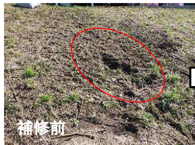
法面陥没した堤防の補修(鳥山川)
