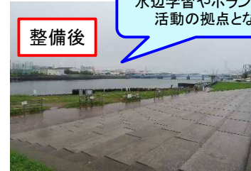
水辺に緩やかな護岸、広場を整備
