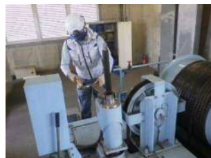
排水門の点検作業
