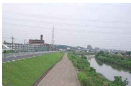
護岸の緑化(横浜市 新羽町地先)
