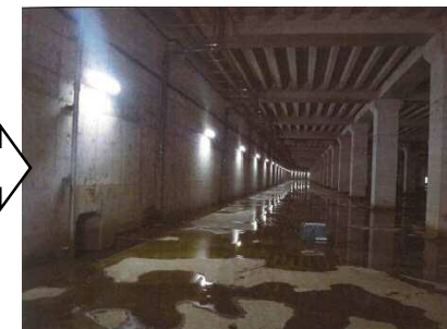
堆積土砂撤去後
