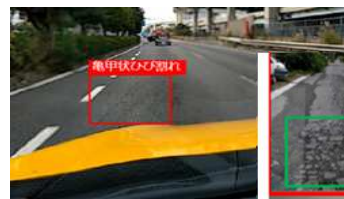
②舗装の損傷状況を自動計測
