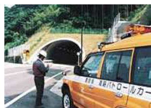
②現地状況を目視確認
