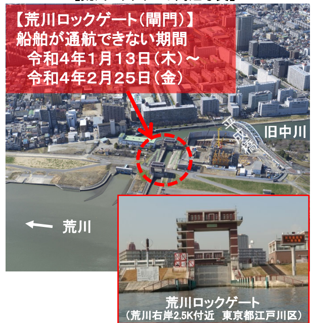
【荒川ロックゲート周辺写真】
