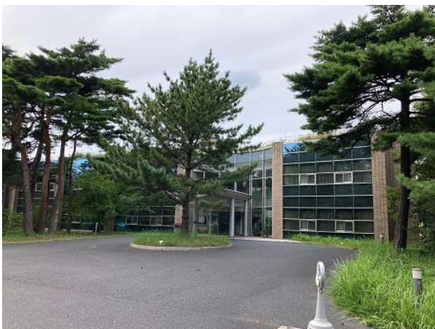
総合管理センター 外観
