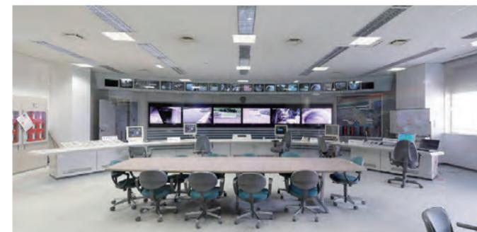
流入施設、ポンプ設備、排水樋管の操作や施設全体を集中監視する中央操作室
