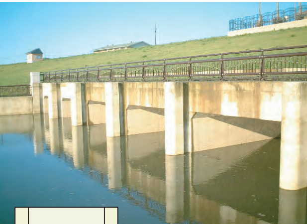
每道排水暗渠都足以輕鬆容納JR山手線「E235系」車廂（寬 2.95m/高 3.62m）
