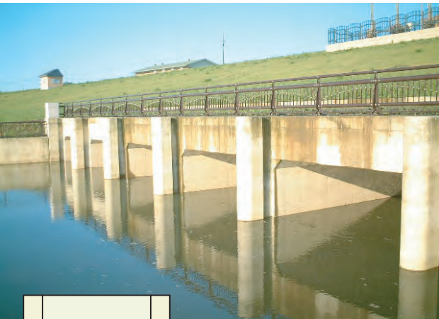
排水暗渠的1个水门能够轻松地容得下一列JR山手线的“E235系”车辆（宽2.95m/高3.62m）
