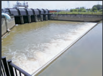
流入设施（第3竖井）
