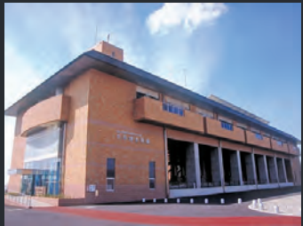
庄和排水泵站
