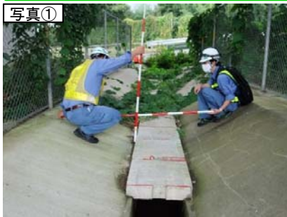
現況写真(既設排水マス)
