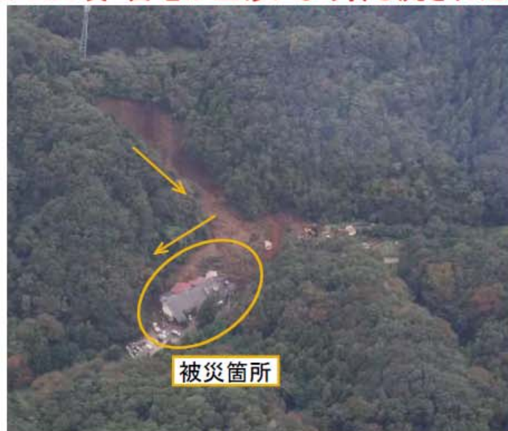
崩壊箇所全景
