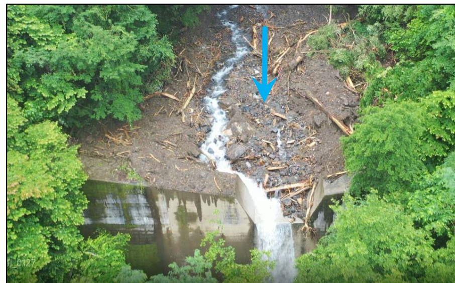
土石流発生後
