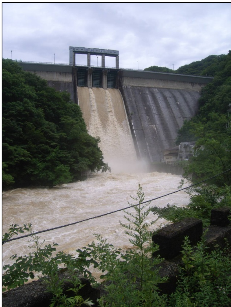
平成23年新潟福島豪雨 藤原ダム放流状況
