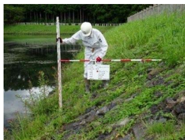
管理者によるため池の点検
