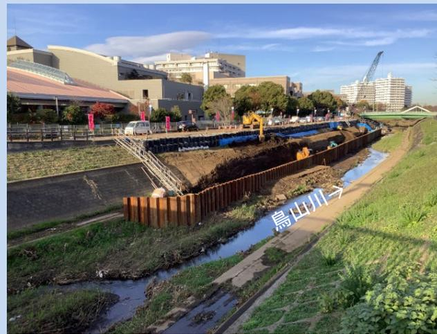
工事中、水が入らないように、護岸施工箇所を囲っています。(令和3年11月)
