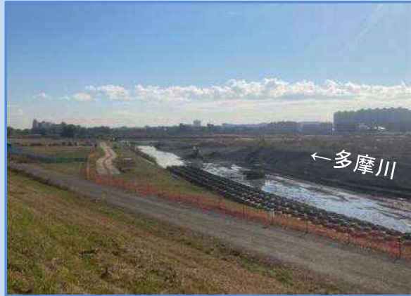
施工箇所に水が入らないようにするため、盛土をしています。 工事完成後は元に戻します。(令和3年11月)
