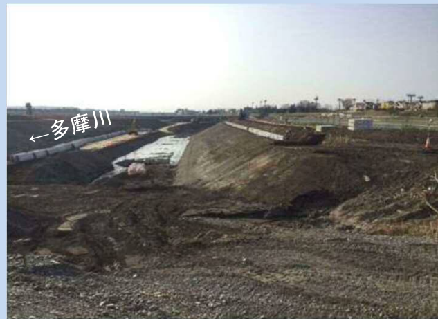
護岸を施工しています。 (令和4年3月)
