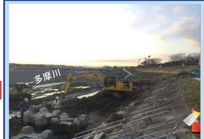
護岸を施工するための準備をしています。 (令和3年12月)
