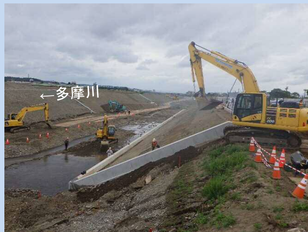
基礎ブロックと帯ブロックを施工し張ブロック面を整えています。 (令和4年4月)
