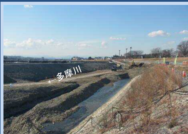
護岸を施工するための準備をしています。 (令和4年 1月)
