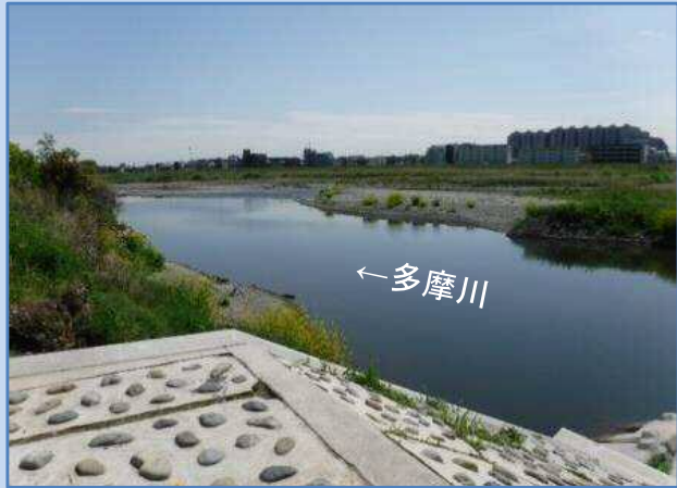
工事着手前(令和3年4月)
