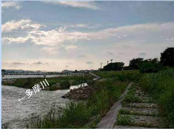
工事着手前(令和3年9月)
