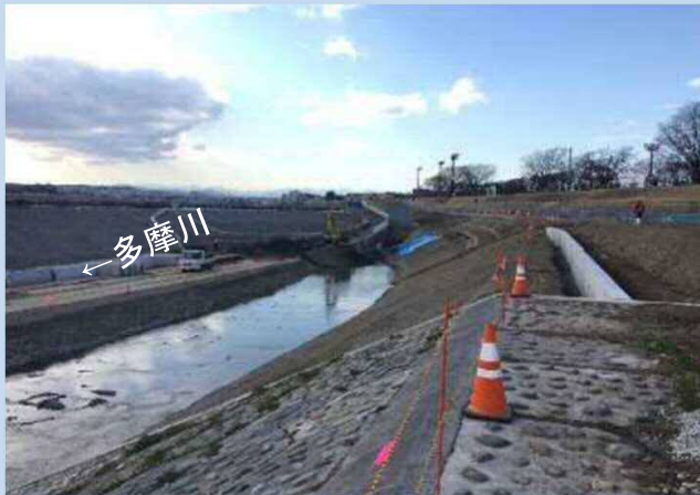
護岸を施工しています。 (令和4年2月)
