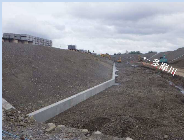
基礎ブロックと帯ブロックを施工し張ブロック面を整えています。 (令和4年4月)
