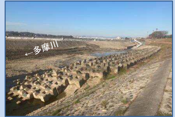
施工箇所に水が入らないようにするため、盛土をしています。 工事完成後は元に戻します。(令和3年11月)
