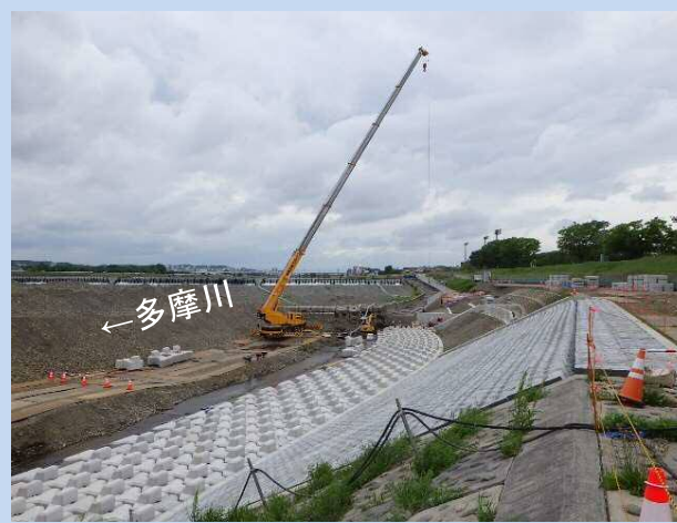
護岸を施工しています。 (令和4年4月)
