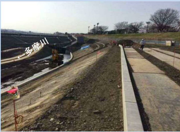
護岸を施工しています。 (令和4年3月)
