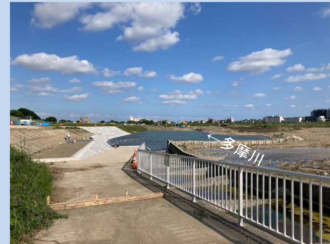
低水護岸が完成しました。 (令和4年5月)
