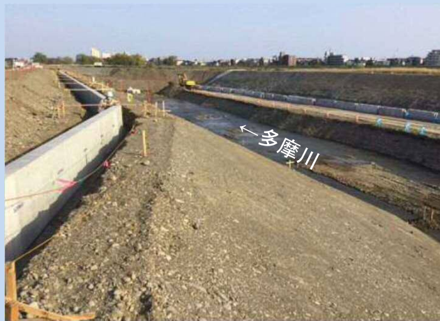
護岸を施工しています。 (令和4年3月)
