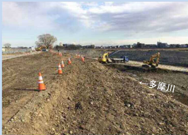
護岸を施工しています。 (令和4年2月)
