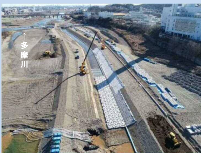
護岸を施工しています。 (令和4年2月)
