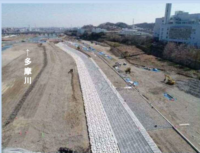
護岸を施工しています。 (令和4年3月)
