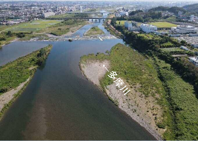
工事着手前(令和3年9月)
