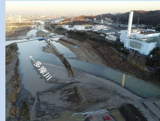
施工箇所に水が入らないようにするため、盛土をしています。(令和3年12月)
