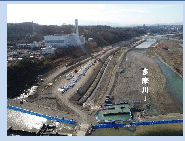
護岸を施工しています。 (令和4年1月)
