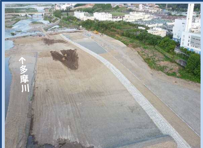
最後の仕上げをしています。 (令和4年4月)
