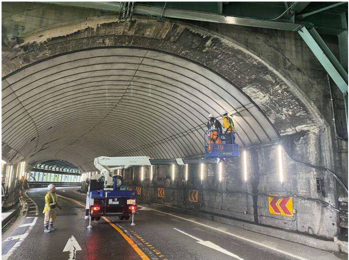
写真①②: 点検状況
