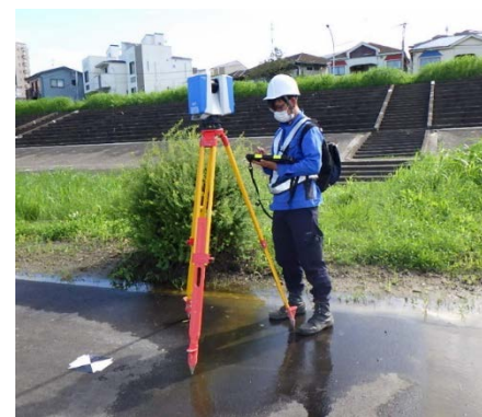
地上レーザー計測
