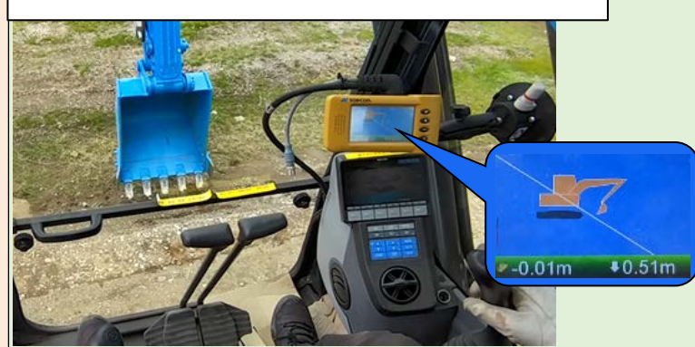
盛土フィールドを活用したICT施工実習
