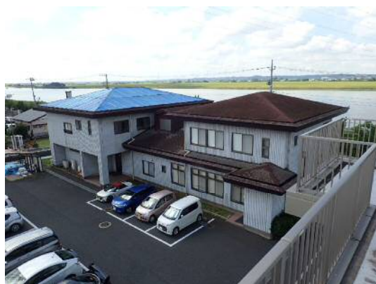
会議・宿泊棟全景
