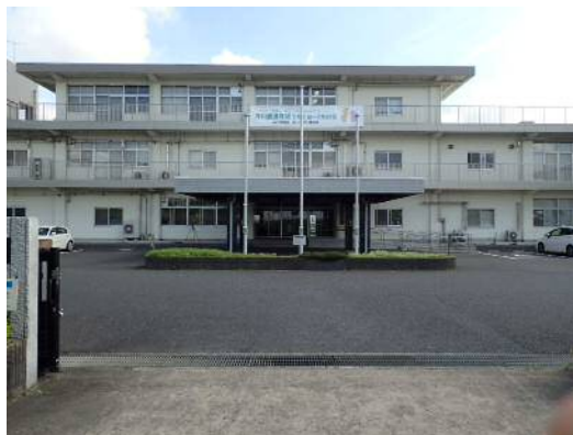
事務所庁舎全景
