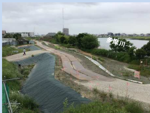
盛土の準備を進めています。 (令和4年5月)
