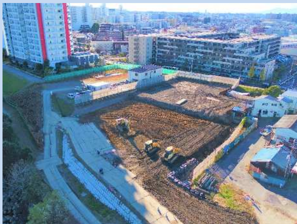
盛土を進めています。 (令和4年12月)
