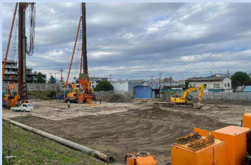
盛土をするため、地盤改良をしています。(令和4年10月)
