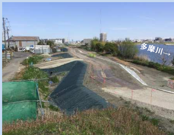
盛土の準備を進めています。 (令和4年4月)
