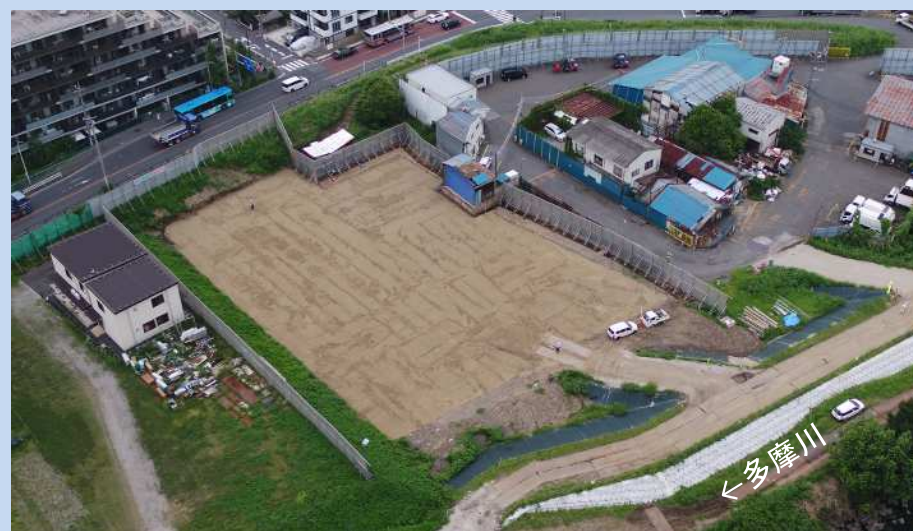
盛土の準備を進めています。(令和4年8月)
