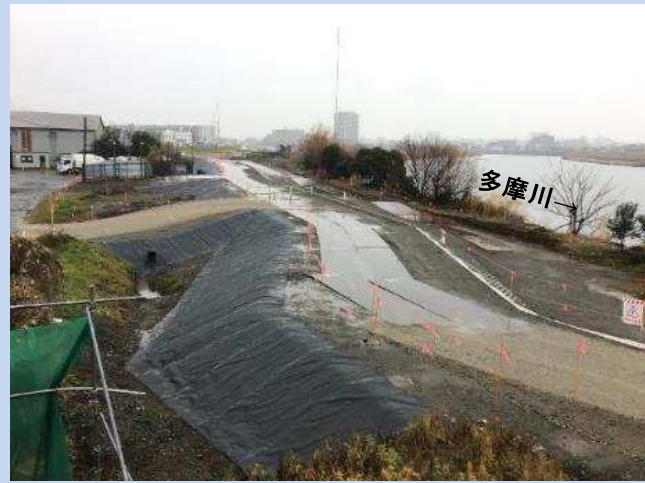
盛土の準備を進めています。 (令和4年2月)
