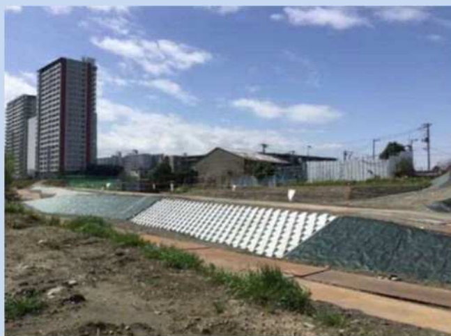
盛土の準備を進めています。 (令和4年3月)
