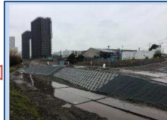
盛土の準備を進めています。 (令和4年1月)
