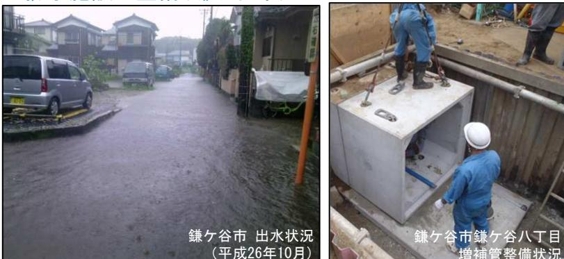
・既設の円形管を流下断面確保に有利なボックスカルバートに布設替え。
