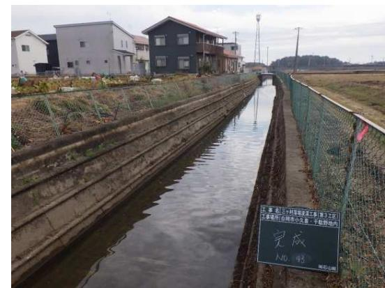
※上記写真は延長約2.4km、水路幅約4mから6m、深さ約3mの水路です。
