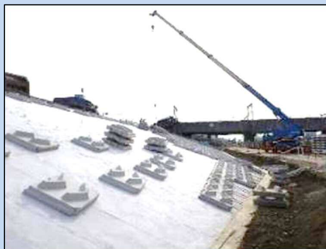
護岸を施工しています。(令和4年1月)
