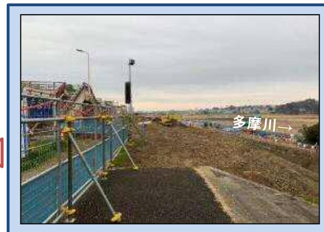
護岸施工箇所の掘削を行っています。(令和4年1月)
