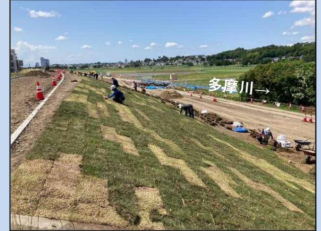
護岸施工箇所の盛土が完了し芝張りをしています。(令和4年5月)
