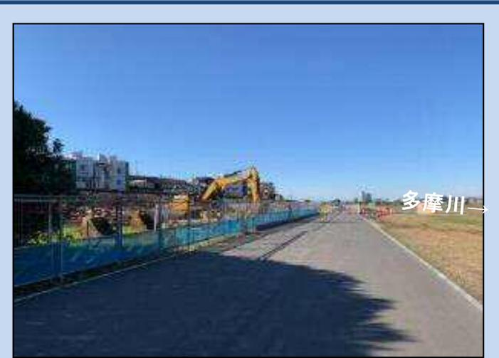
護岸施工箇所の掘削を行っています。(令和3年12月)
