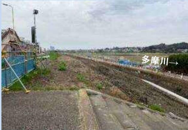
護岸施工箇所の掘削を行っています。(令和4年3月)
