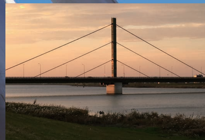
水郷大橋／国道51号／千葉国道事務所
