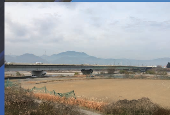
長野大橋／国道18号／長野国道事務所
