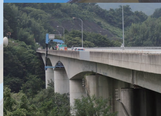
月夜野大橋／国道17号／高崎河川国道事務所
