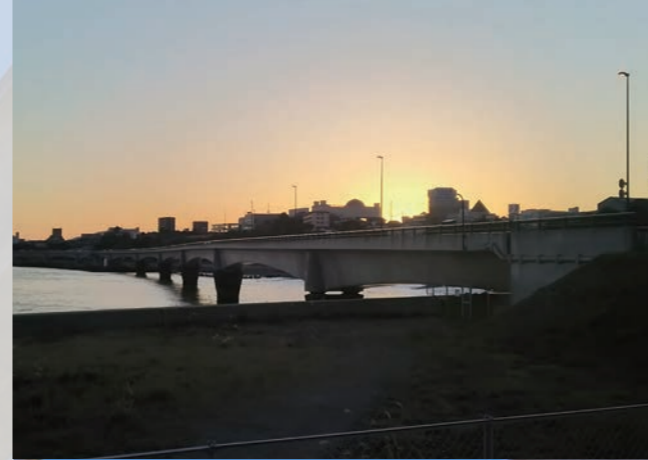
旭高架橋/国道6号/常陸河川国道事務所
