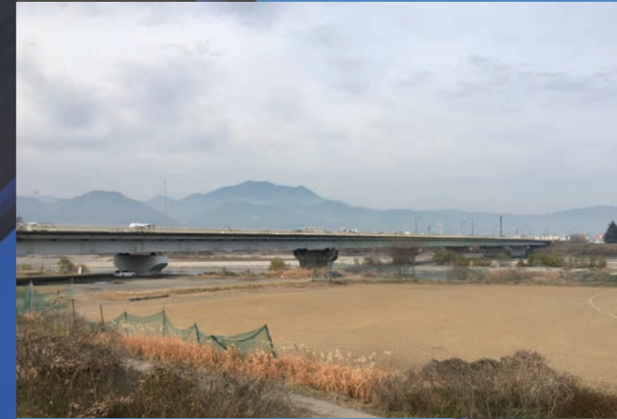
長野大橋/国道18号/長野国道事務所
