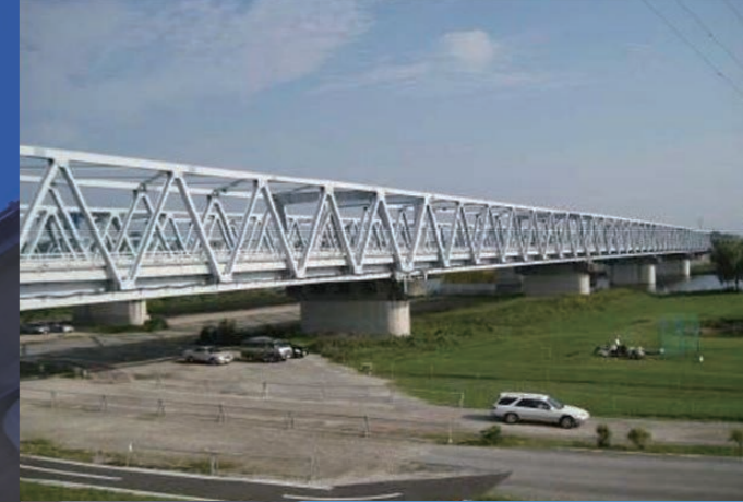
葛飾大橋(下り)/国道298号/首都国道事務所
