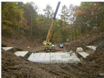
船ヶ沢川西砂防堰堤の施工状況
