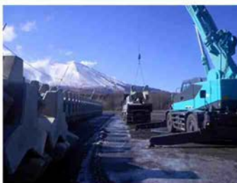
濁沢 据付工事状況
