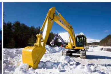
無人化施工による掘削試験
