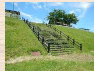
親水護岸にある階段の点検
