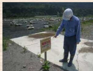
注意看板の確認・設置
