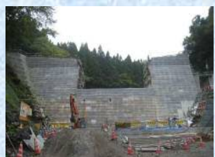
中央部分の コンクリート打設完了しました。
