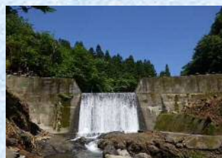
施工前です。大きく、厚くします。
