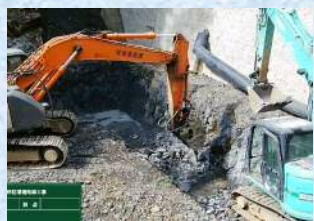
固い地山を掘りました
