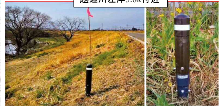
越水・決壊監視システム
