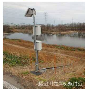
越辺川左岸5.8k付近 危機管理型水位計
