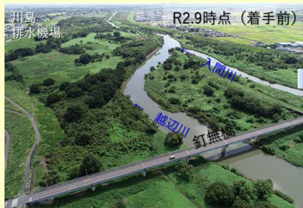
釘無地区(川島町)河道掘削状況
