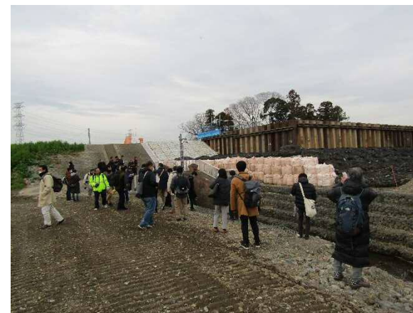
緊急復旧工事状況の見学
