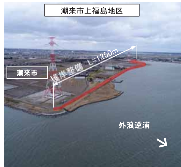
令和元年度施工箇所(波浪対策)
