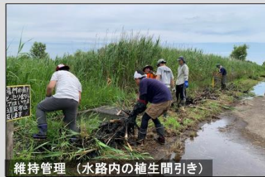
維持管理(水路内の植生間引き)
