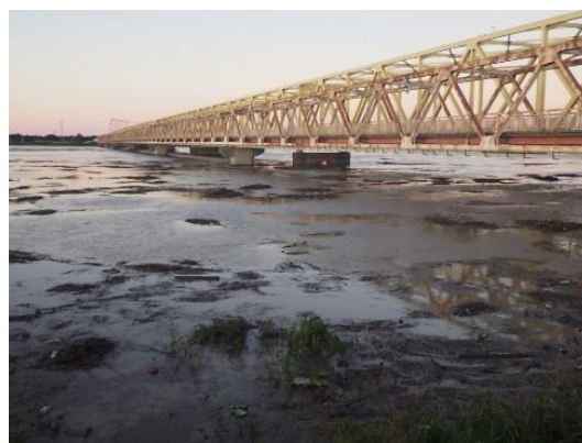
芽吹橋水位観測所付近(野田市)
