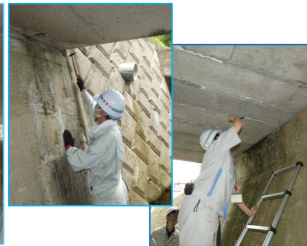
床版下や下部工における打音検査の方法などの実習
