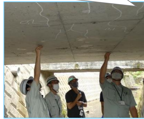
床版下や下部工における打音検査の方法などの実習
