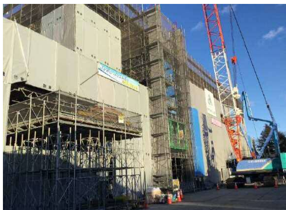
外部施工状況
