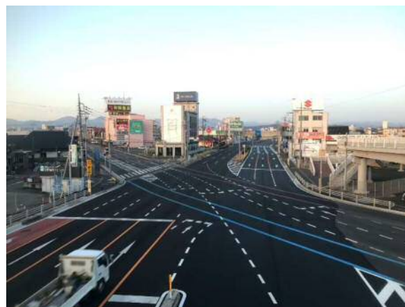
電線共同溝(舗装)完成
