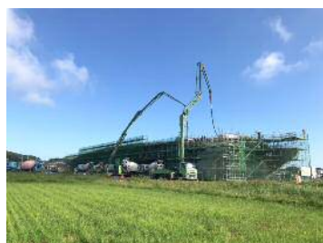
コンクリート打設の状況
