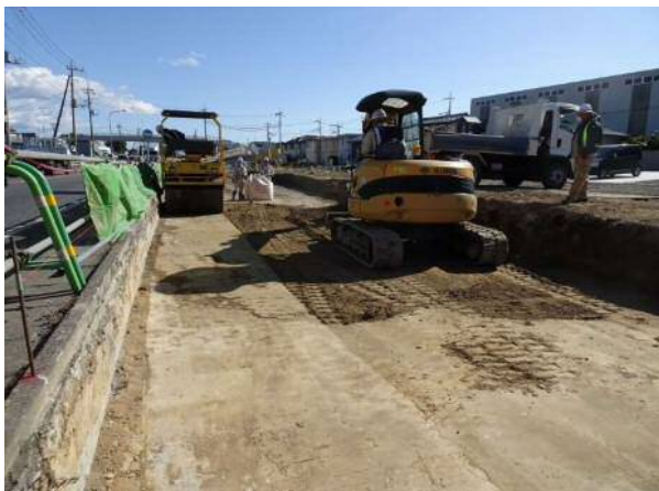
地盤改良工施工状況
