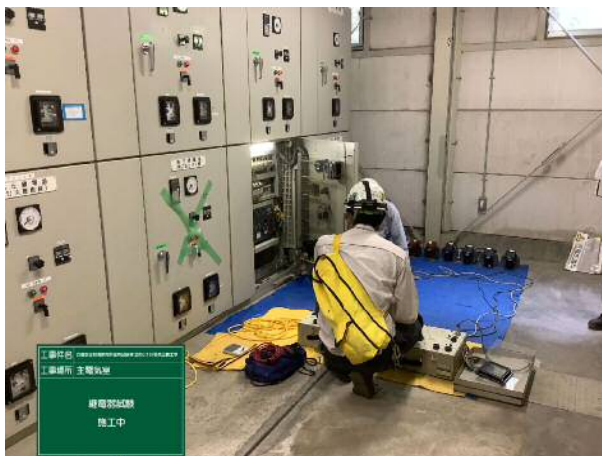
継電器試験実施状況
