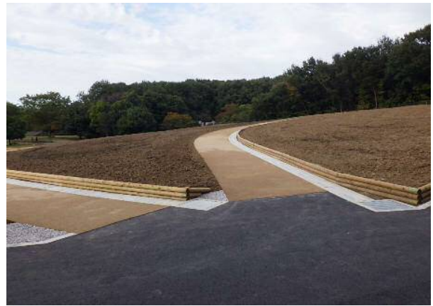
完成(敷地造成・園路広場整備)
