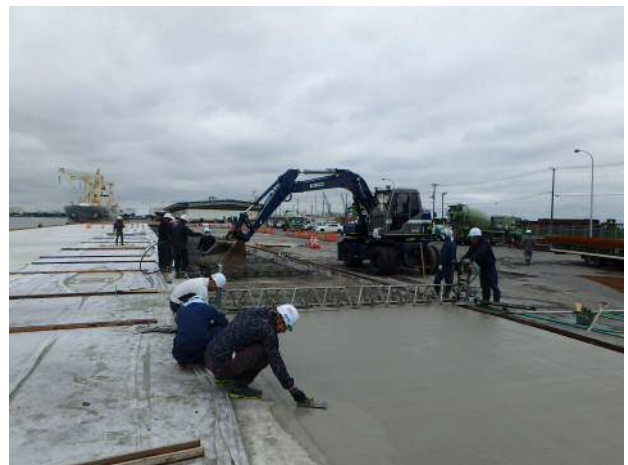
施工状況(コンクリート舗装)
