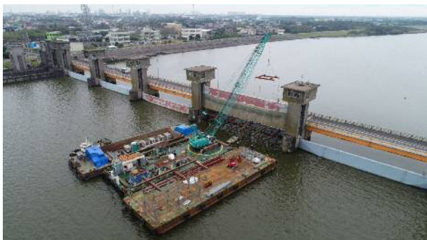
仮設工 施工状況
