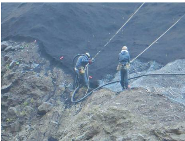
植生工施工状況
