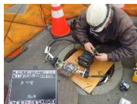
光ケーブル切替作業
