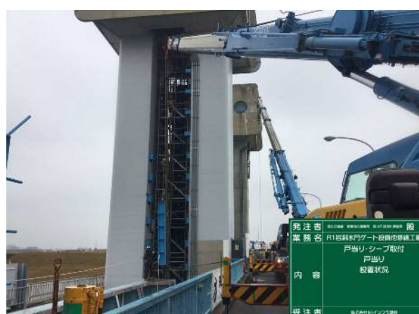
戸当り取付状況
