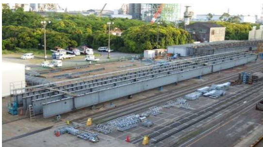
仮組立状況(工場製作工)
