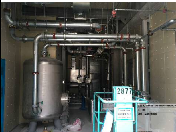
機器・配管施工状況(保温施工前)
