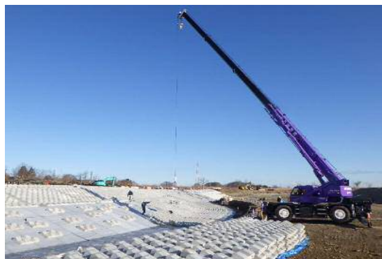
大型連節ブロック施工状況
