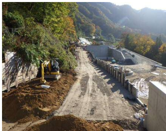
帯鋼補強土壁施工状況
