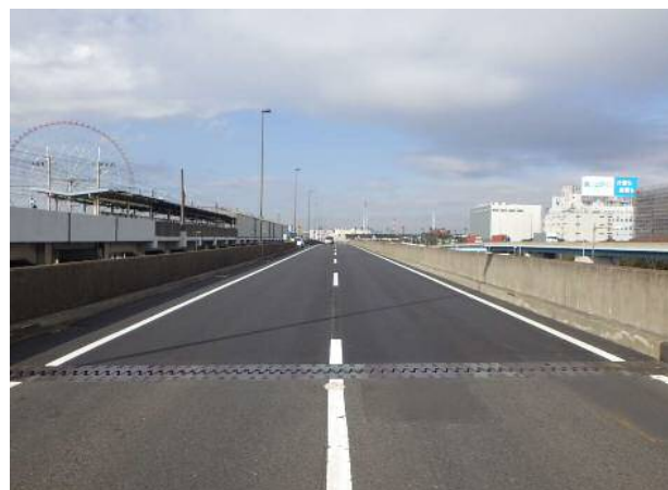
完成(葛西高架橋)
