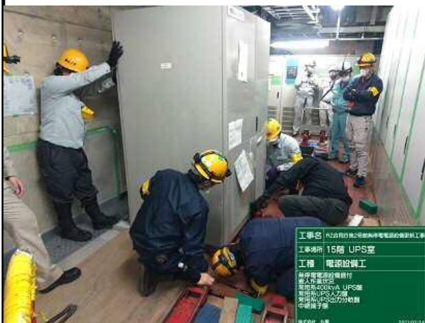
機器搬入状況
