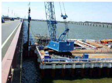
既設橋に近接した矢板打設状況 躯体コンクリートの打設状況
