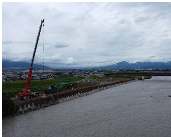
災害緊急対応施工中
