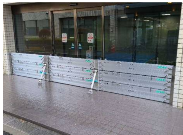
脱着式止水板 完成
