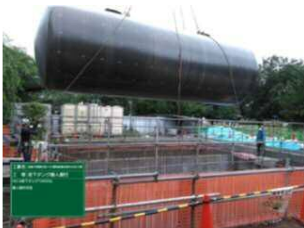
新設地下タンク据付状況
