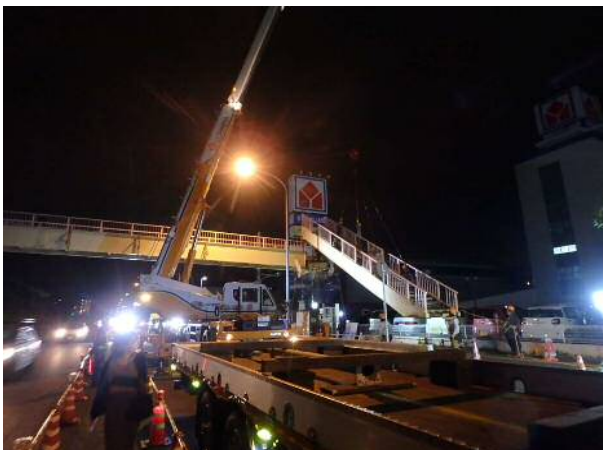
幕張2丁目歩道橋階段撤去状況
