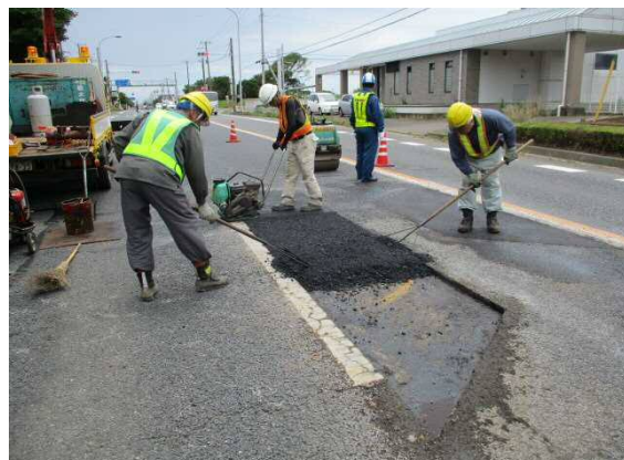
路面補修の状況
