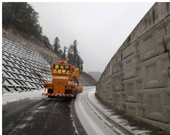
除雪作業状況
