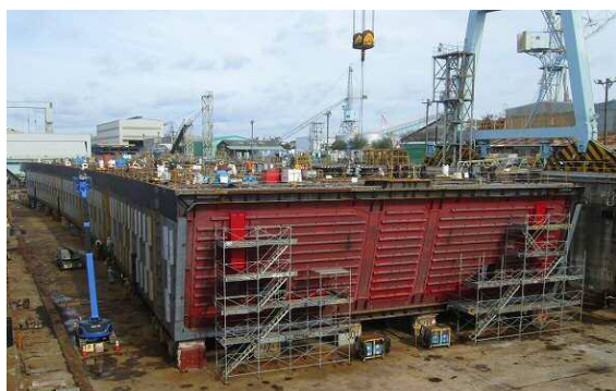
沈埋函(6号函)大組立(最終函)
