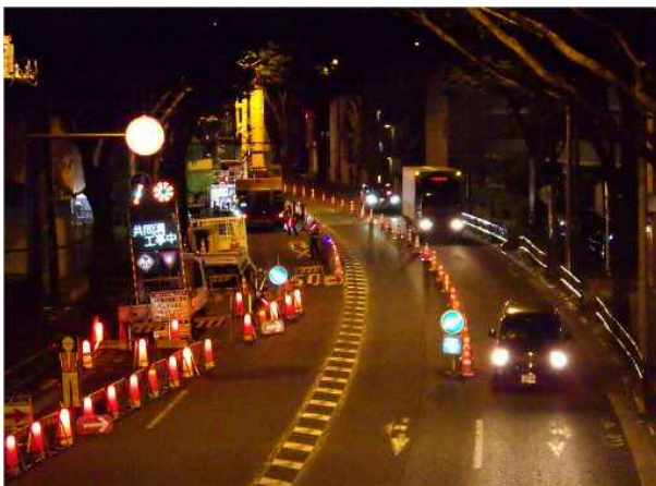
夜間の通行規制状況（立坑施工）
