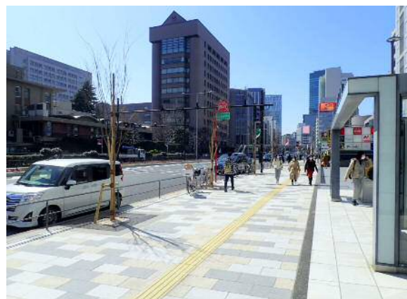
青山工区 歩道整備工事 完成
