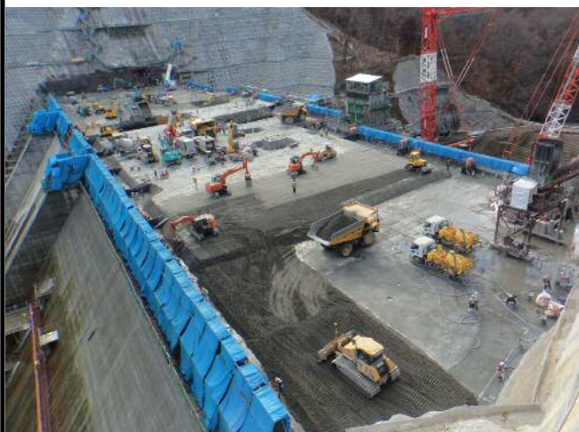
本体コンクリート打設状況
