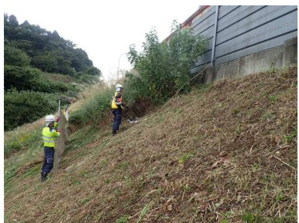
除草工施工状況
