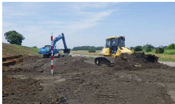
築堤盛土 施工状況
