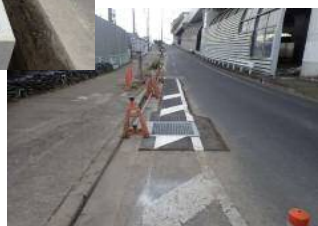
排水構造物改修(冠水対策)
