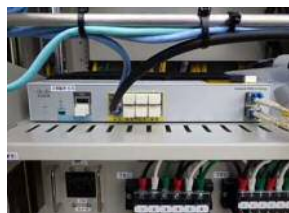
防塵キャップ取付状況
