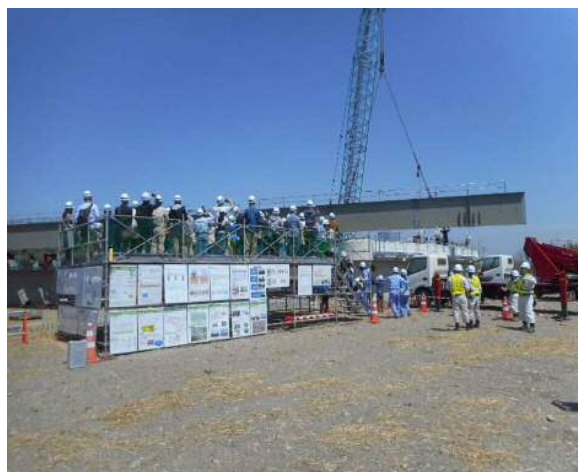
橋桁架設状況
