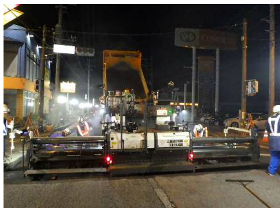
夜間工事の状況
