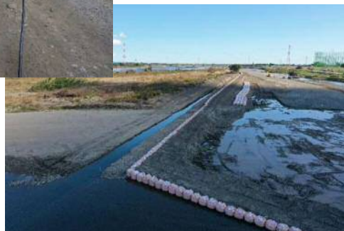
仮締切施工状況
