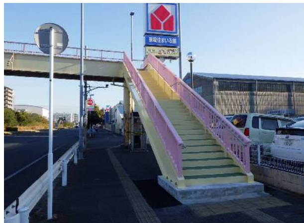
幕張2丁目歩道橋階段完成
