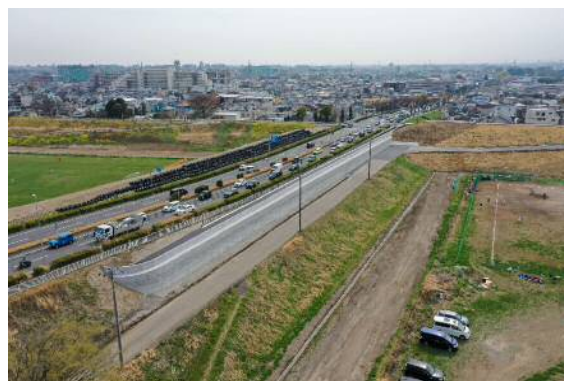
完成(上流工区:志木市宗岡地先)
