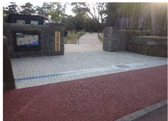
完成(擁壁、園路舗装)
