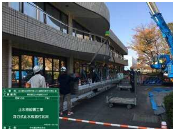
浮力起伏式止水板 施工状況
