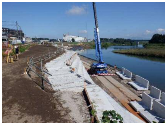
堤防護岸 大型ブロック積 施工状況
