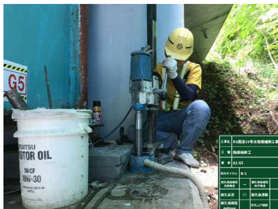
既設支承撤去施工状況
