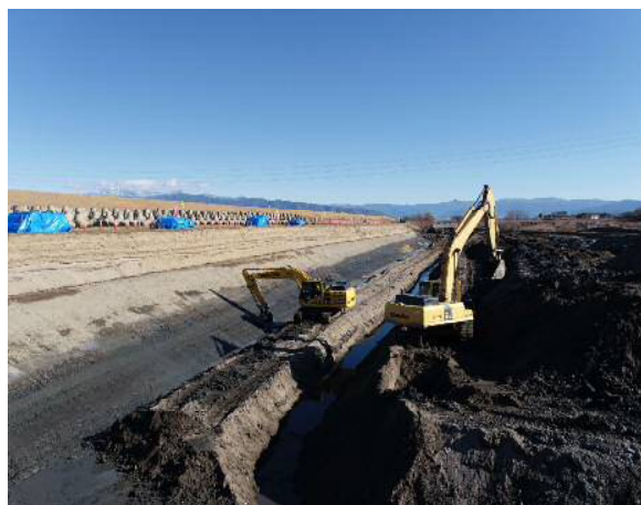
MCバックホウによる掘削状況
