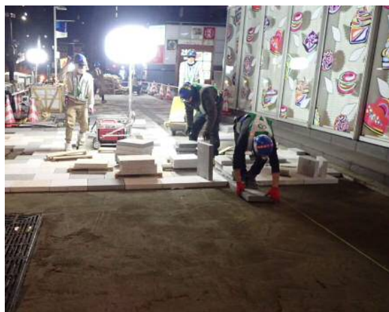
青山工区 歩道整備工事 施工状況
