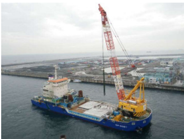
写真-2 撤去したPC桁の積込状況
