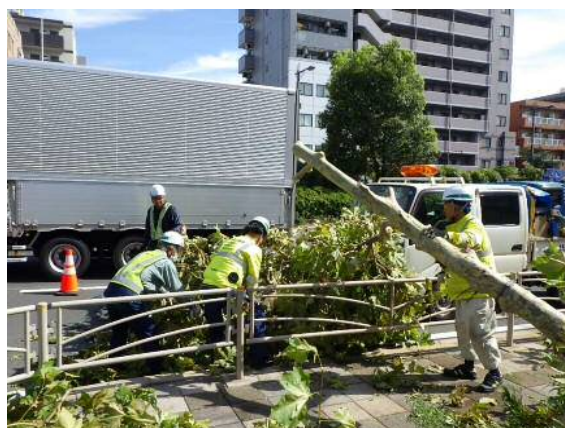
倒木作業施工状況
