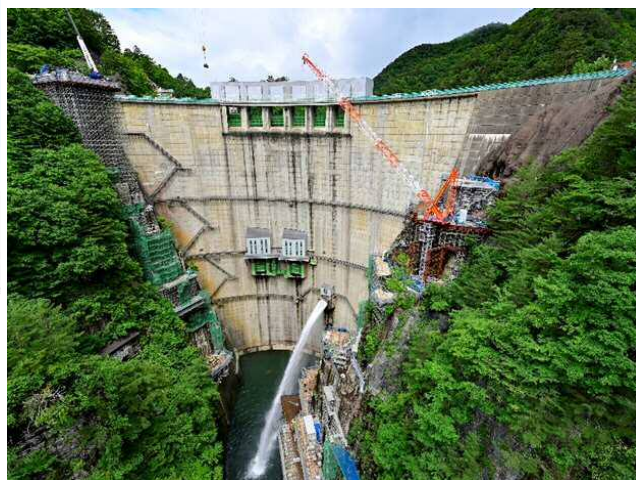
施工状況全景(左右岸の仮設足場・クレーン)
