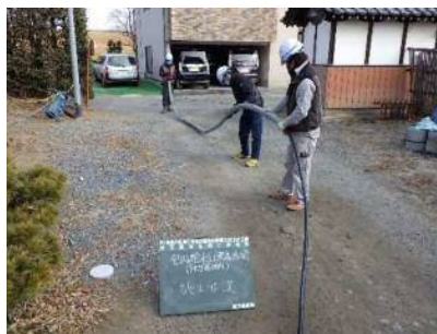
仮設水道 敷設状況
