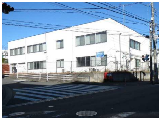
完成後の施設全景
