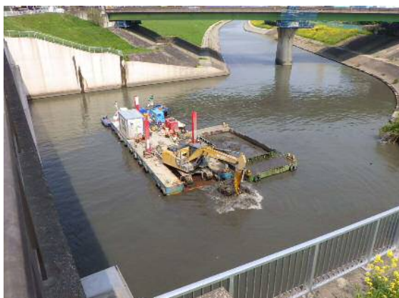
台船による浚渫施工状況
