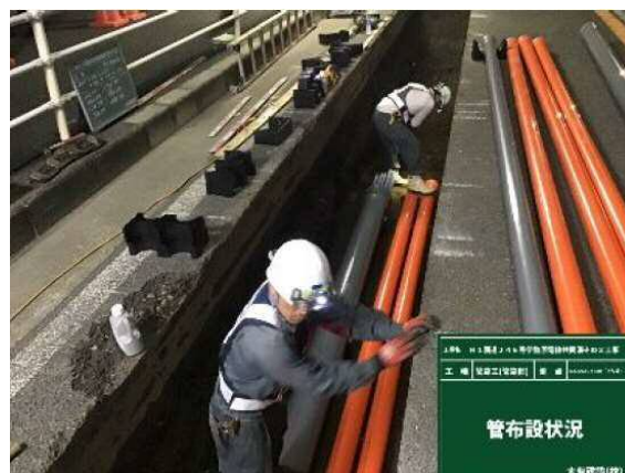
管路施工状況
