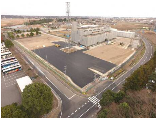
那珂機場場内整備 完成
