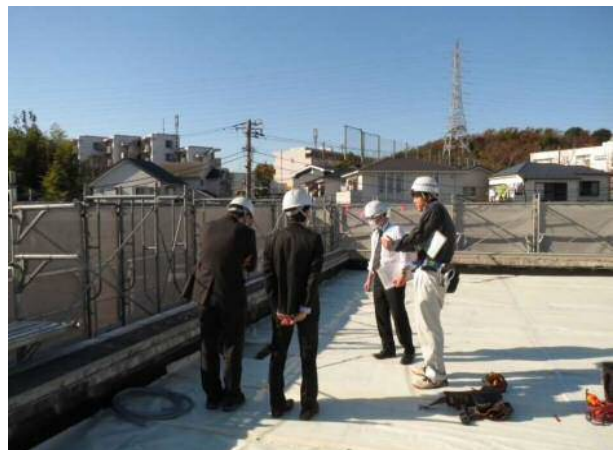
現場代理人による入居官署への説明状況
