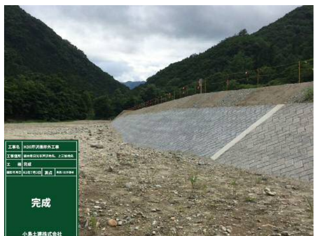
完成(男鹿川護岸)
