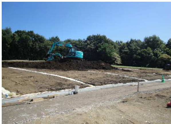
施工状況(敷地造成・園路広場整備)
