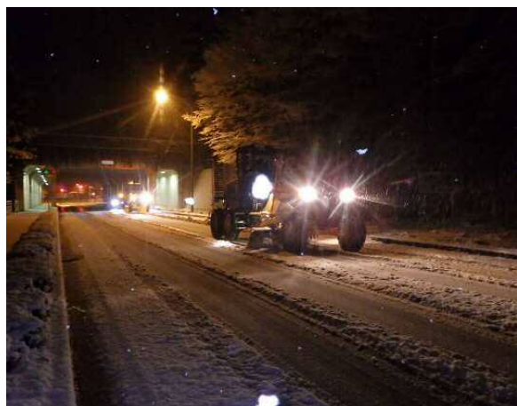
除雪作業状況
