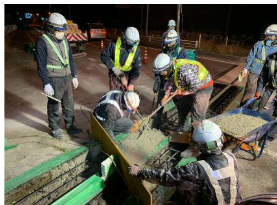
橋梁ジョイント部の補修
