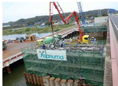
既設橋に近接した矢板打設状況 躯体コンクリートの打設状況
