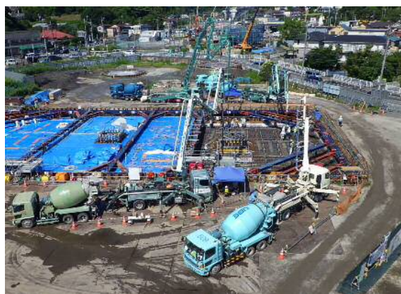
コンクリート打設状況
