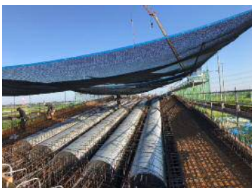
鉄筋組立の状況
