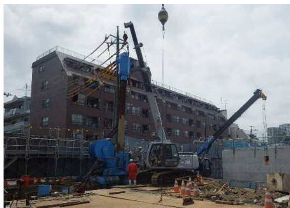
低空頭鋼矢板圧入施工状況
