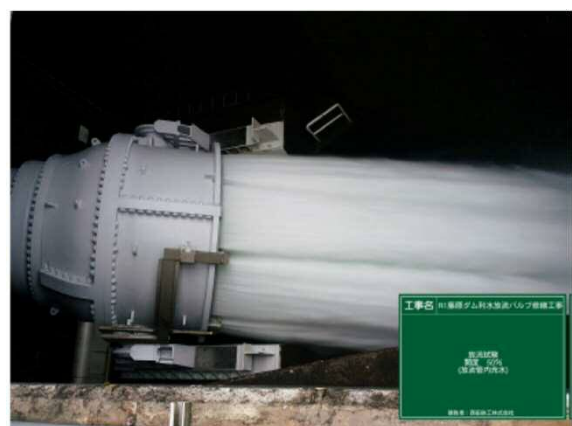
放流試験 開度50% 90m 3 /s (放流管内充水)
