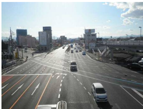
電線共同溝施工前
