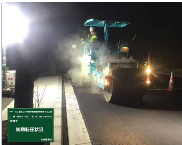
初期転圧施工状況
