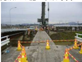
完成又は施工状況写真
