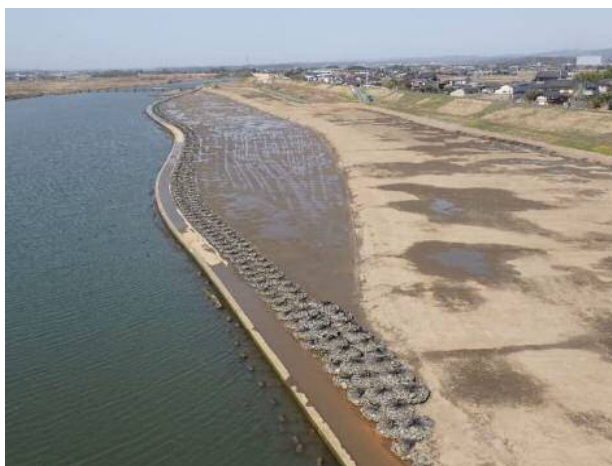
完成(河道掘削)
