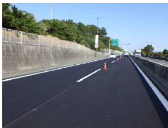
西湘バイパス 完成
