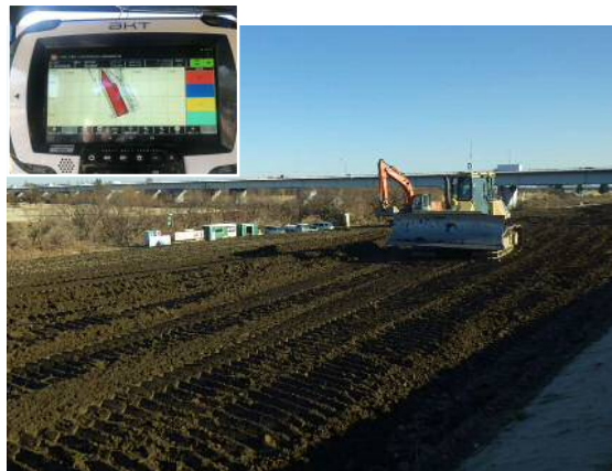
ICT施工(盛土工)施工状況
