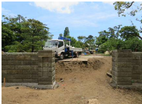
エントランス施工状況
