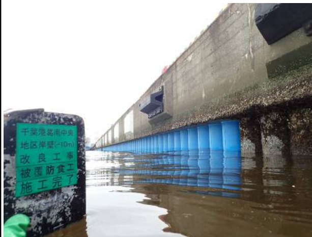
維持補修工(ペトロラタム被覆)完成
