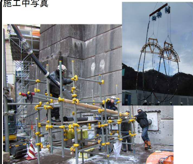
長大なアンカーテンドン吊上・挿入の施工状況
