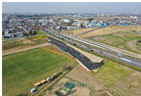
完成(下流工区:志木市宗岡地先)
