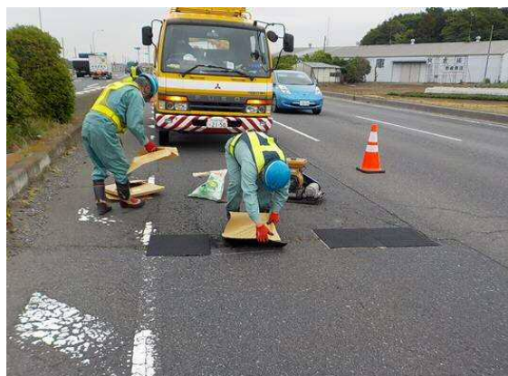
クラック補修マットの施工状況
