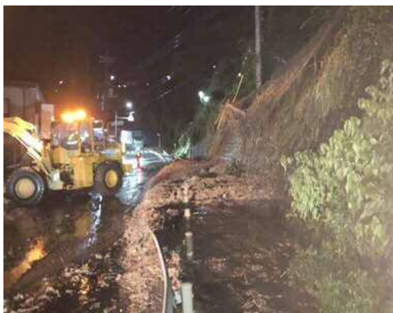
法面崩壊土砂の撤去状況
