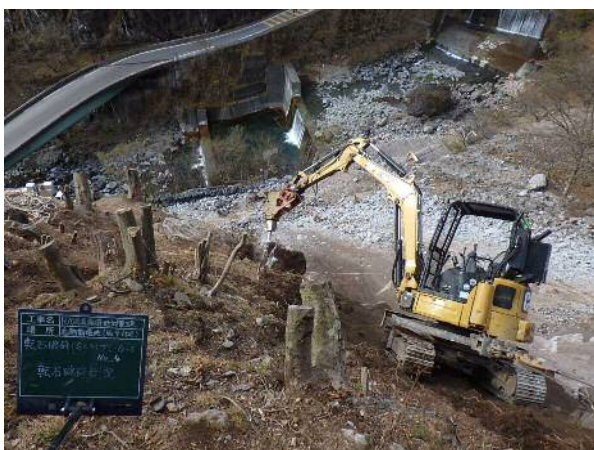
SCMIによる転石破碎状況
