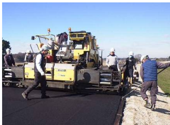
大輪工区 アスファルト舗装 施工状況
