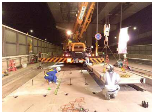
PRCコンクリート舗装板施工
