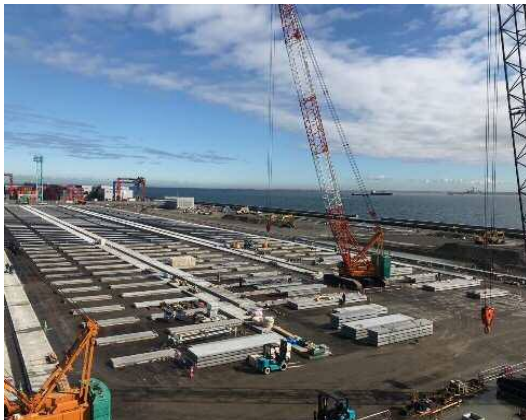
施工状況(PPC版敷設状況)
