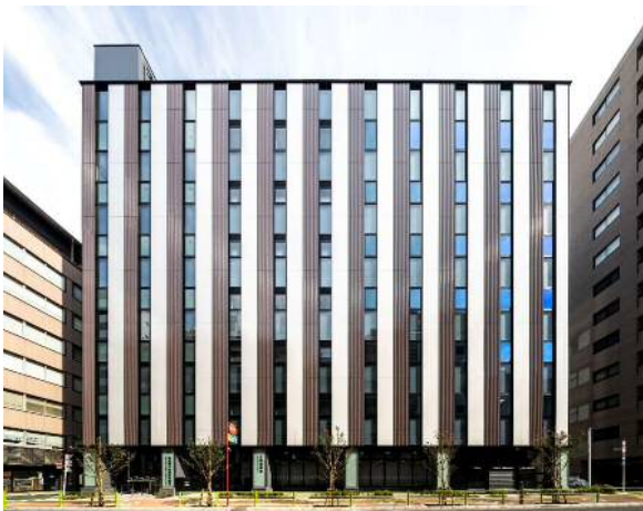
工事完成施設全景
