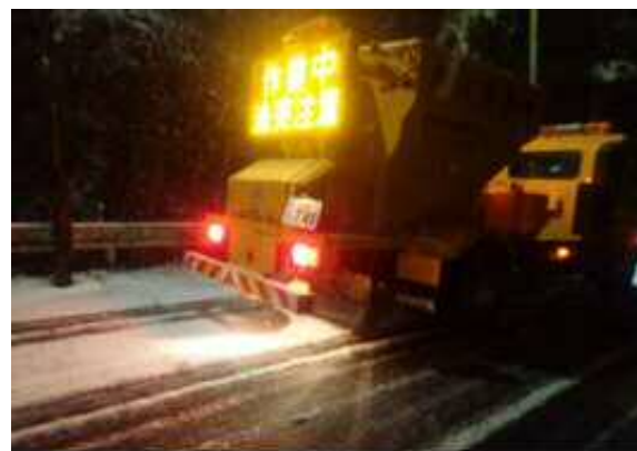
融雪剤散布状況
