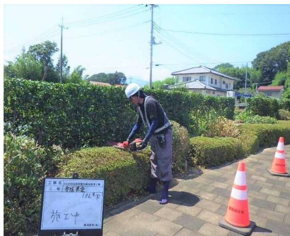
寄植剪定の施工状況
