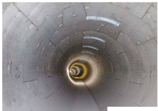
完成（シールド工）
