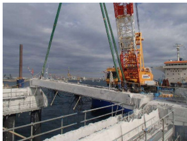
写真-2 被災したPC桁の撤去状況
