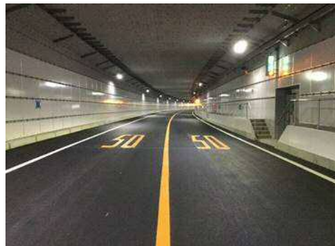
完成後(トンネル内・6号函付近)
