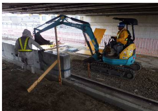
橋梁下における近接施工状況
