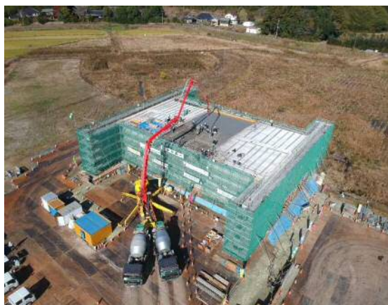
函渠施工状況
