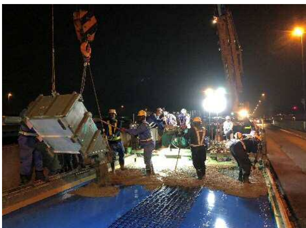
SFRC打設状況
