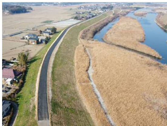
大輪工区 完成
