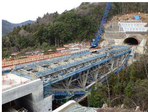
鋼桁架設施工状況
