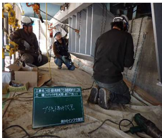
水平力分担構造ブラケット設置施工状況
