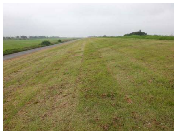
除草完成状況
