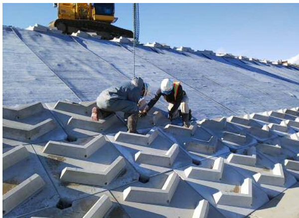
護岸ブロック施工状況
