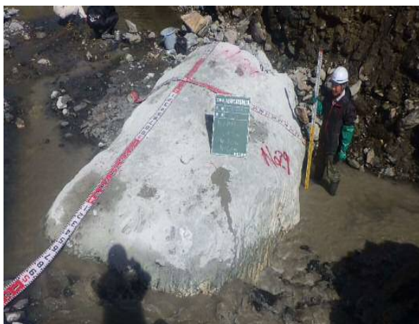
掘削施工状況
