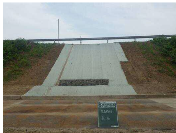
法面災害復旧完成
