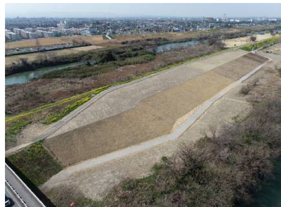
完成(川越市古谷上地先)
