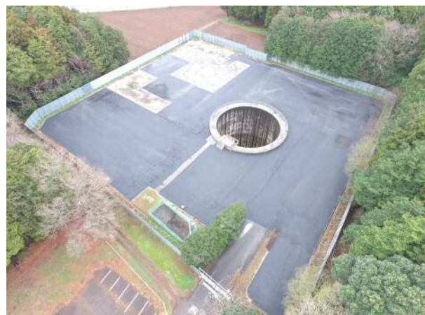
茨城立坑 完成
