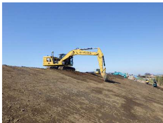
築堤盛土 施工状況
