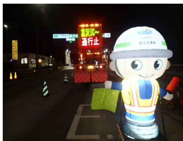
規制帯設置状況
