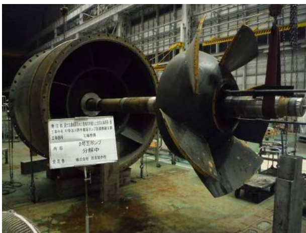
整備前ポンプ分解状況
