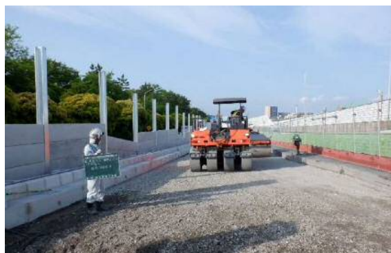
路盤施工状況
