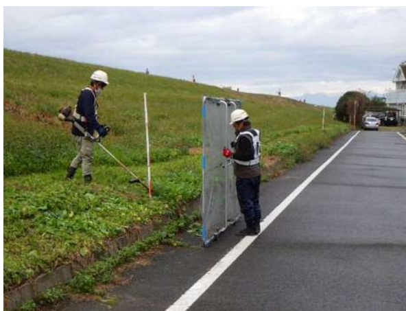
除草作業状況
