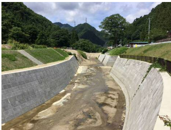
完成(芹沢護岸)
