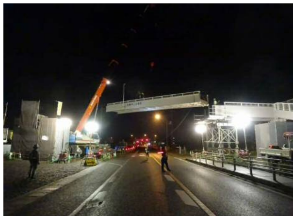
歩道橋架設状況
