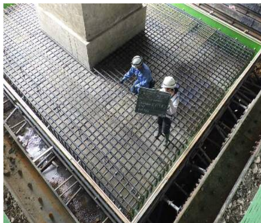
フーチング増し厚工鉄筋・型枠組み立て完了状況
