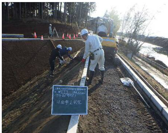
築堤および法面整形
