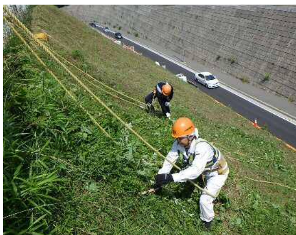
除草作業状況
