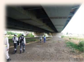
橋梁の橋脚周りが適切に管理されているかを検査
