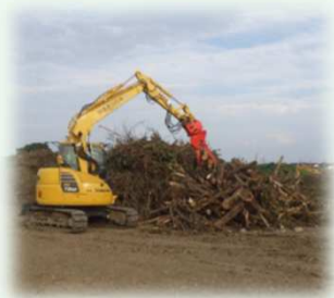
伐採樹木搬出状況
