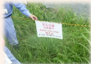
危険箇所に看板設置
