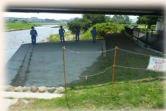
河岸に危険がないかを点検
