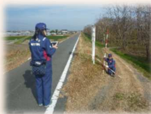
法面欠損箇所の点検
