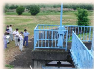
樋管のゲートが正常に作動するかを検査
