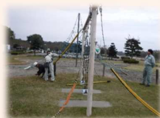
公園の遊具が撤去できるかを検査
