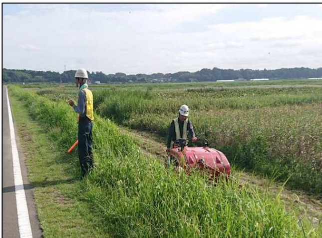
堤防草刈状況
