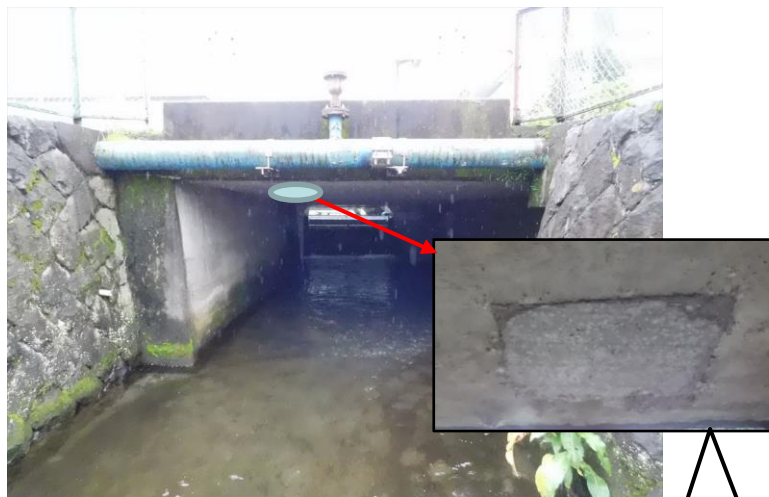
直営補修を行った橋梁
