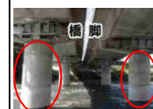
＜橋梁の耐震対策＞
