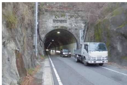
<仁方隧道の状況>
