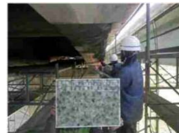
修繕の様子(断面修復)
