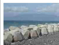
＜消波・根固ブロック＞
