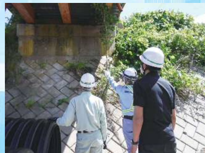
現地調査の様子
