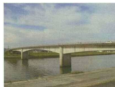
<天大橋の状況>
