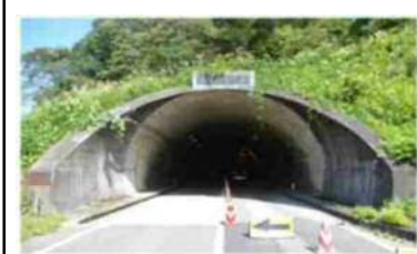
トンネルの例
