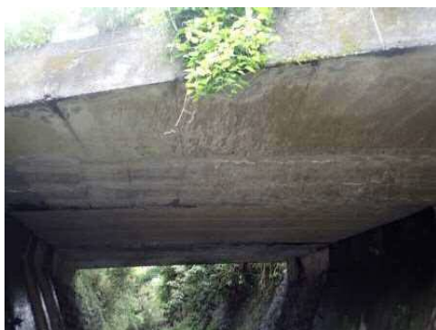
床版下面の状態
