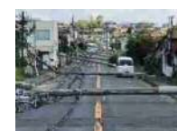
＜電柱倒壊による道路閉塞＞
