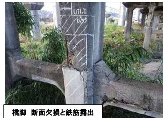
橋脚 断面欠損と鉄筋露出
