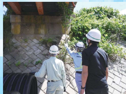
現地調査の様子
