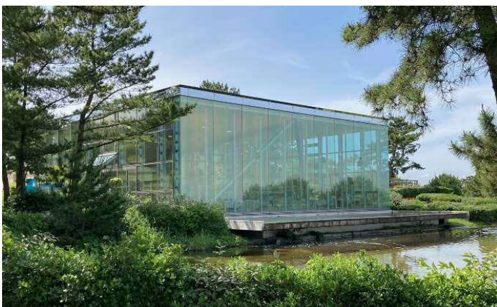
ガラスハウス 外観
