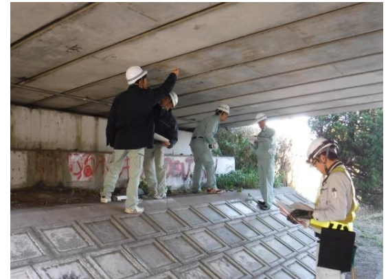
【橋梁点検研修会】
