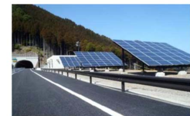
道路を活用した太陽光発電
