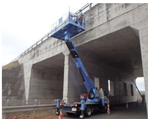
【高所作業車による点検作業】
