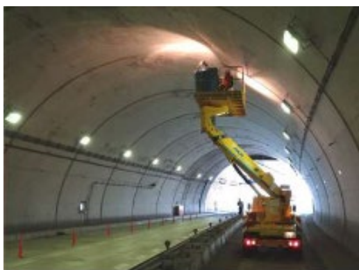
【高所作業車による点検作業】
