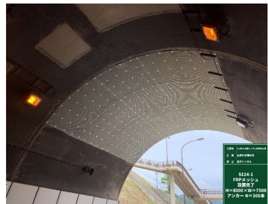
【剥落防止工 (FRP メッシュ工)】
